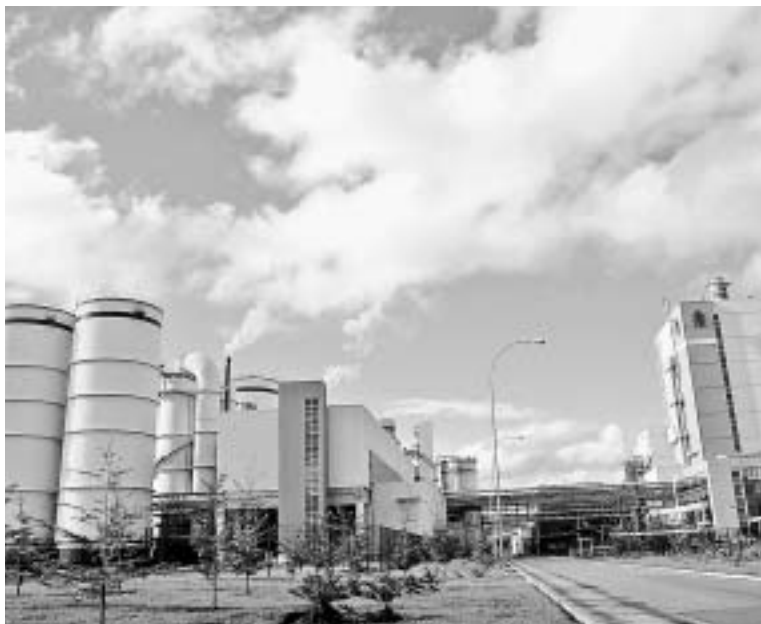
CELCO se instaló en febrero de 2004, a 60 kilómetros de Valdivia. En el complejo se blanquea la pulpa kraft para luego ser exportada para la fabricación de otros productos.
